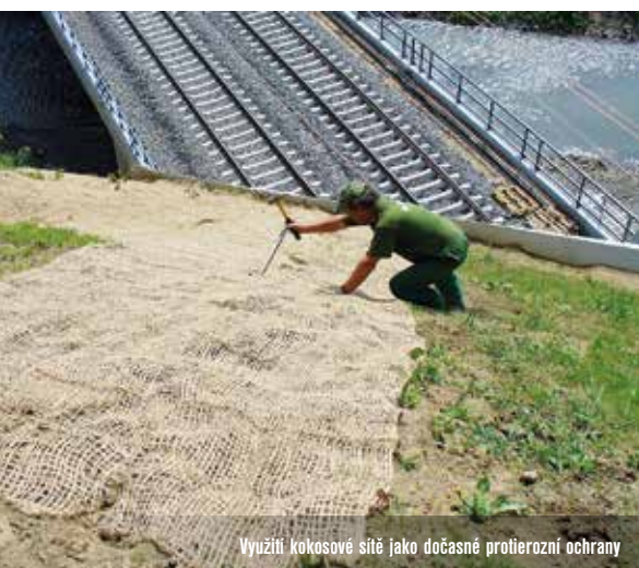
Princip protierozní ochrany svahu pomocí plošných produktů
