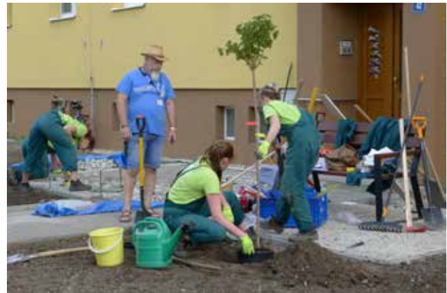
Oproti projektu došlo nakonec den před zahájením k výměně stromů, místo jabloní se vysadili javory. Chybička se v objednávce vloudila, jabloně měli příliš vysoko nasazenou korunku a stínili by majitelům dolních bytů. Javory byli v dané chvíli jedinou dostupnou náhradou a děkujeme firmě Arboeko za pružnou reakci a sponzorský dar.
